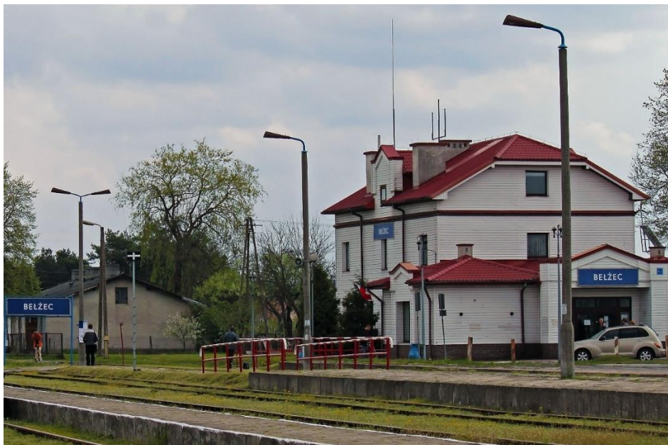
Ryc. 83. Stacja kolejowa w Bełżcu – potencjalnie jeden z kluczowych punktów dla połączeń kolejowych obszaru Partnerstwa
